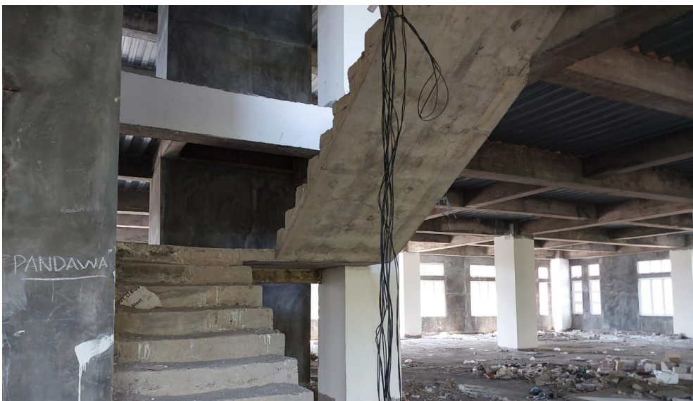
Pada 2018 lalu, pengerjaannya hanya sampai empat lantai saja, lalu dilanjutkan kembali pada Mei 2019. Namun belum juga rampung, keramik belum dipasang, ruangan belum dicat dan kabel instalasi belum terpasang.
