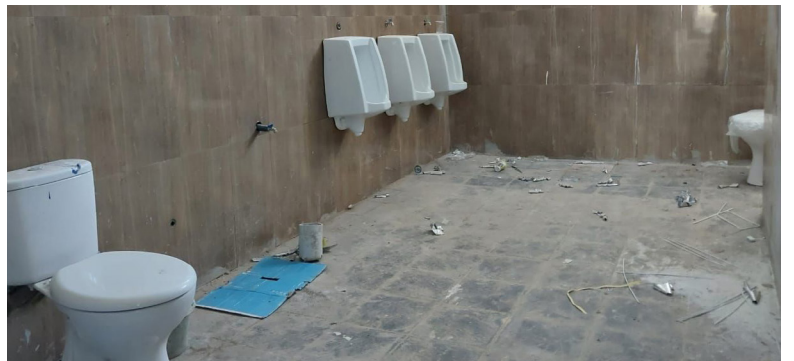
Terdapat tiga lantai yang sudah di pasang keramik yakni lantai lima, enam, dan tujuh. selain itu toiletnya juga telah dilengkapi urinoir.
